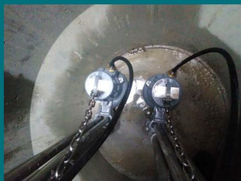
zwei Pumpen in einem Schacht für alternierenden Einsatz
