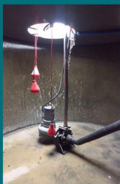
Abwasserpumpe mit Niveauregler
